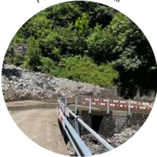
Ponte zona Cortignelli
